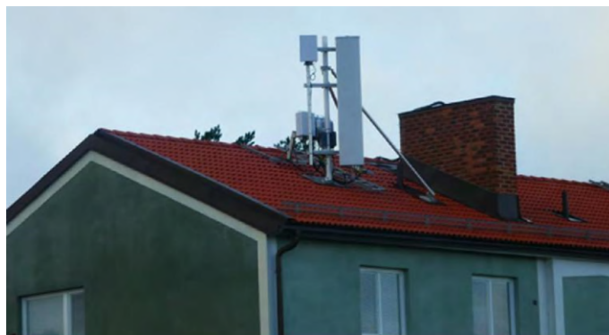
Figure 2 Station de base 5G sur le toit d'un immeuble de trois étages situé à 60 mètres de l'appartement étudié.
